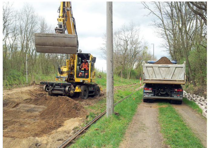
BILD 5: Gleislos mit Baustraße
